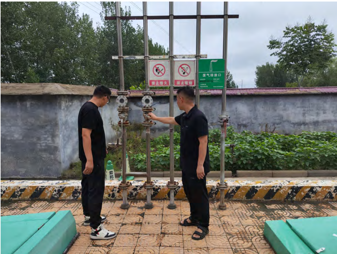
曹县青岛中路加油加气站现场照片
