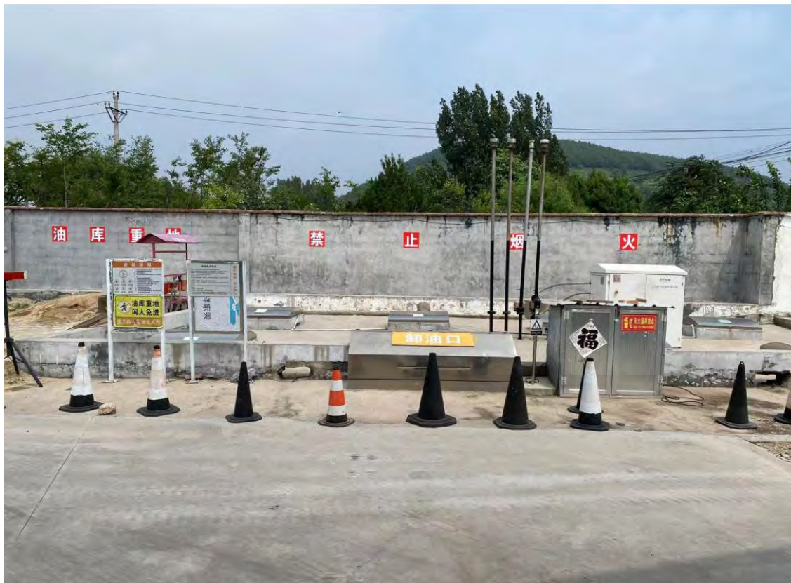
济南卓星石化有限公司现场照片
