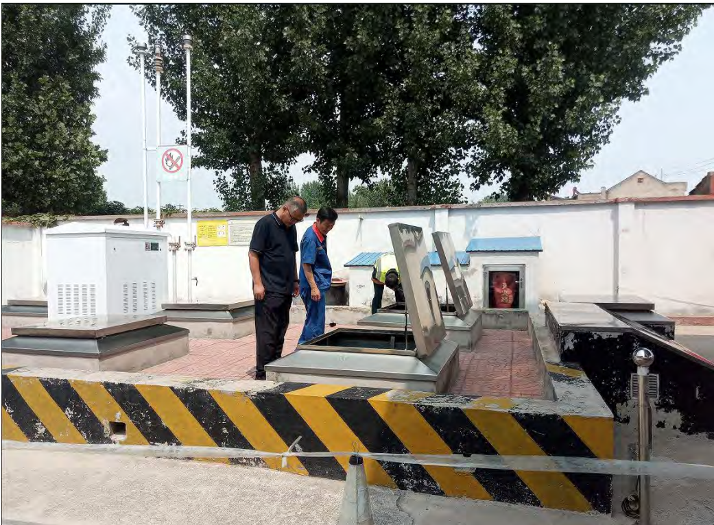
莱芜长城石化有限公司姚口路加油站现场照片
