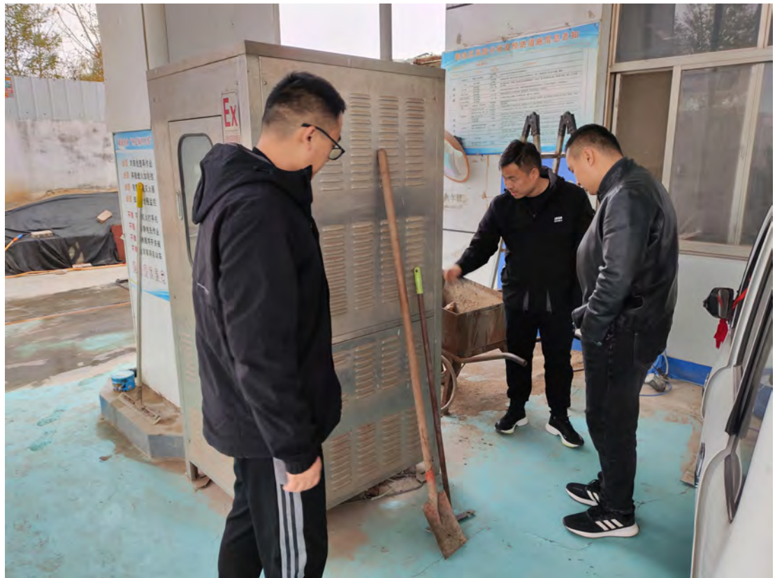
巨野县田庄镇东风加油站现场照片
