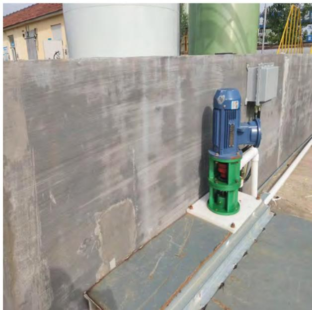
图 7-2 防火堤孔洞采用不燃材料封堵
