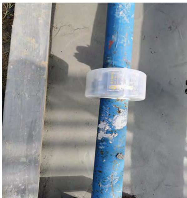
图 7-1 法兰设置防喷溅设施
